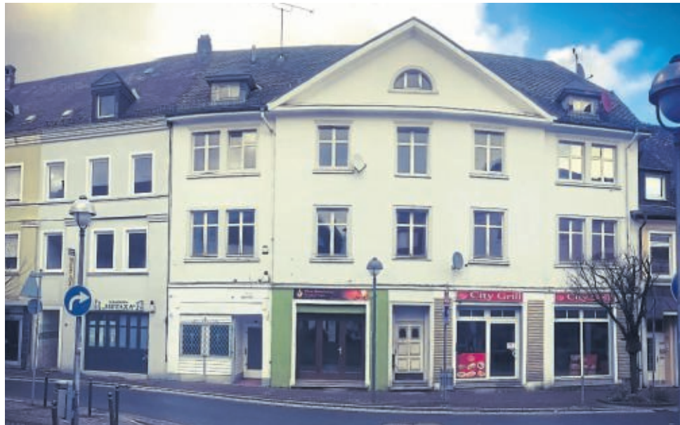
Die beiden Häuser an der Hauptstraße sollen saniert werden – während dieser Zeit können sie nicht genutzt werden.
