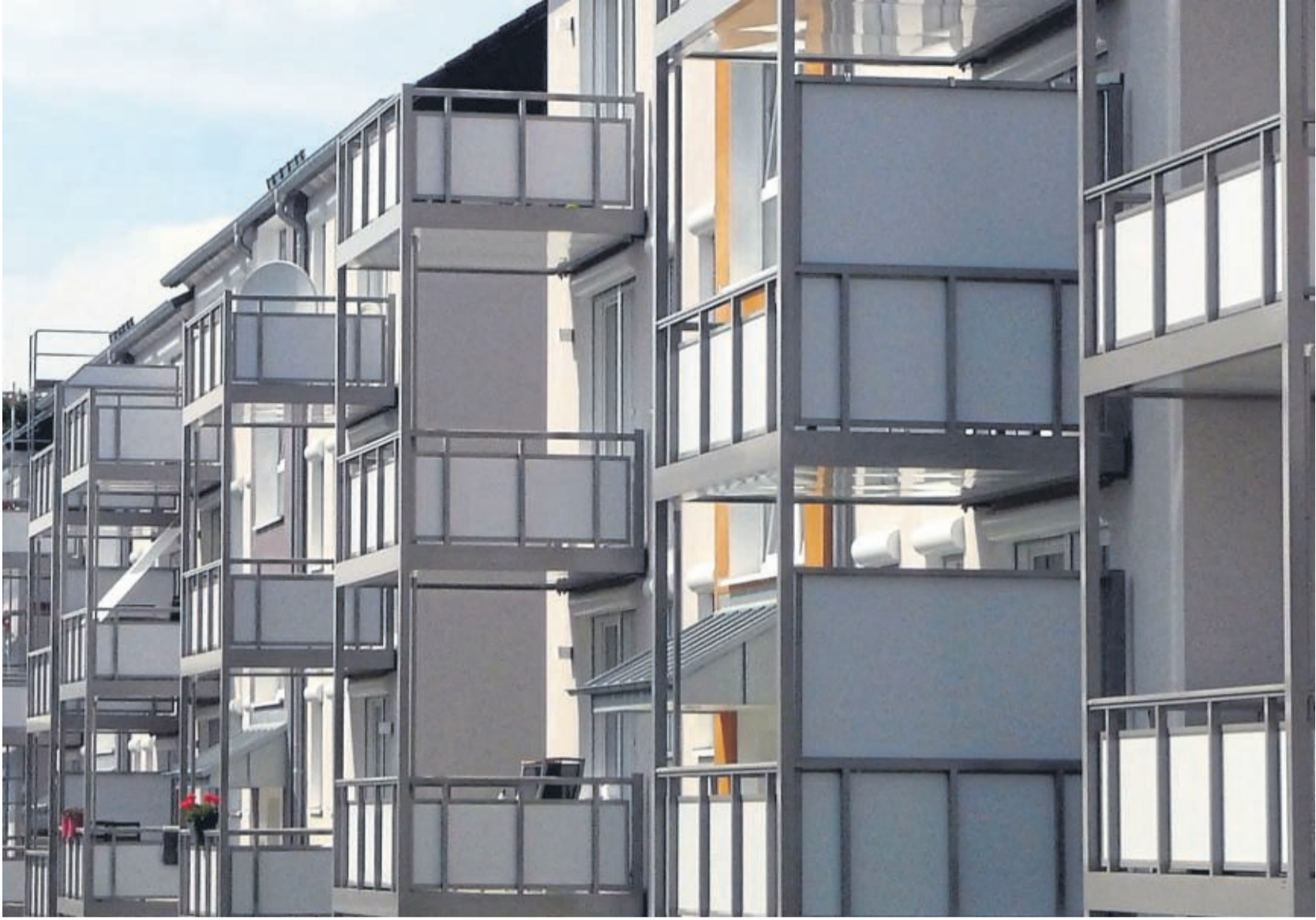
Die Meinerzhagener Baugesellschaft – hier MBG-Gebäude an der Dränkerkampstraße – ist der größte Vermieter in der Stadt.
