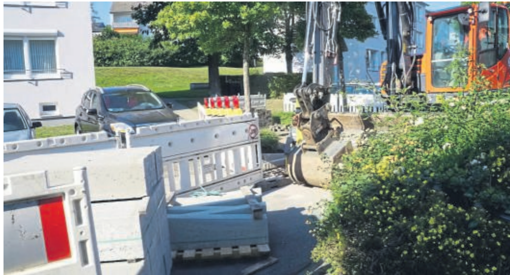
Eine Attendorner Firma ist mit den Arbeiten betraut. Nach dem Rückbau der Hubbel entsteht eine ebene Durchfahrt auf der Dränkerkampstraße.
