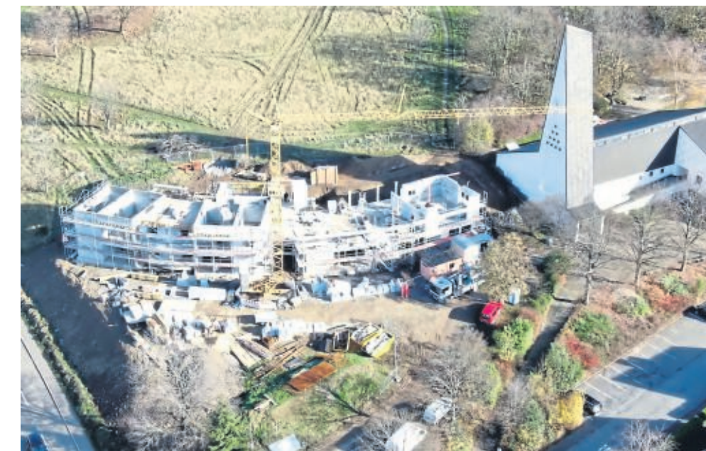
Direkt neben der Johanneskirche entsteht die neue Kita „Farbenspiel“. Im Frühsommer 2021 soll die Einrichtung bezugsfertig sein.
