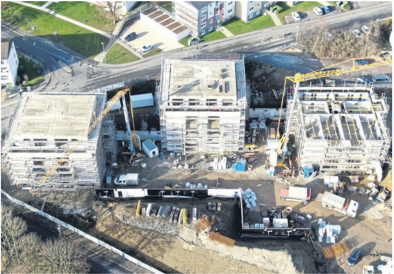
Die Häuser A und B (links und Mitte) stehen im Rohbau. Haus C ist bereits in Arbeit, für den Bau von Haus D wurden die Vorarbeiten in Angriff genommen. Das Fröbel-Karree wächst.
