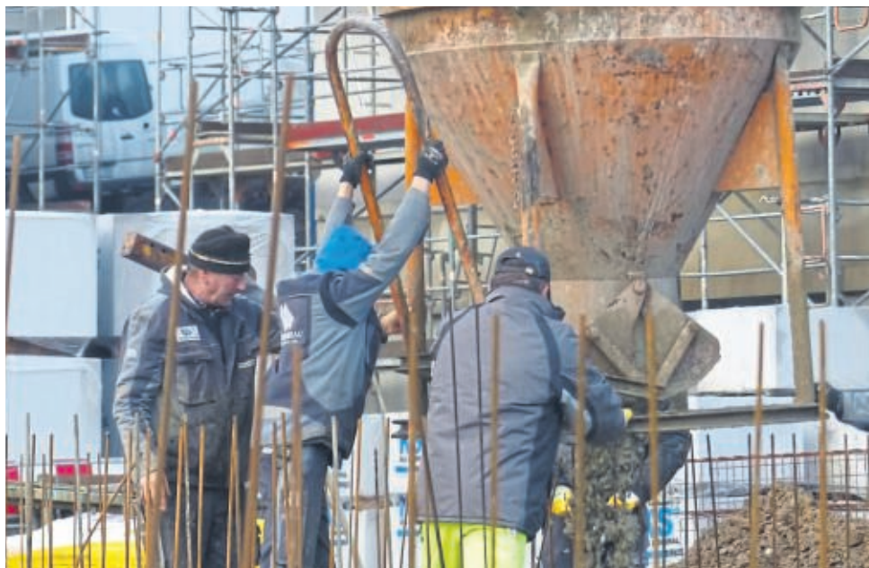
Drei Häuser stehen im Rohbau, eines wird derzeit „hochgezogen“.
