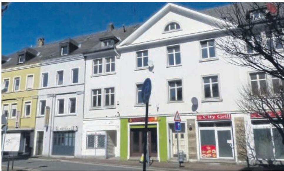
Keine Schmuckstücke: Die Häuser im jetzigen Zustand.
